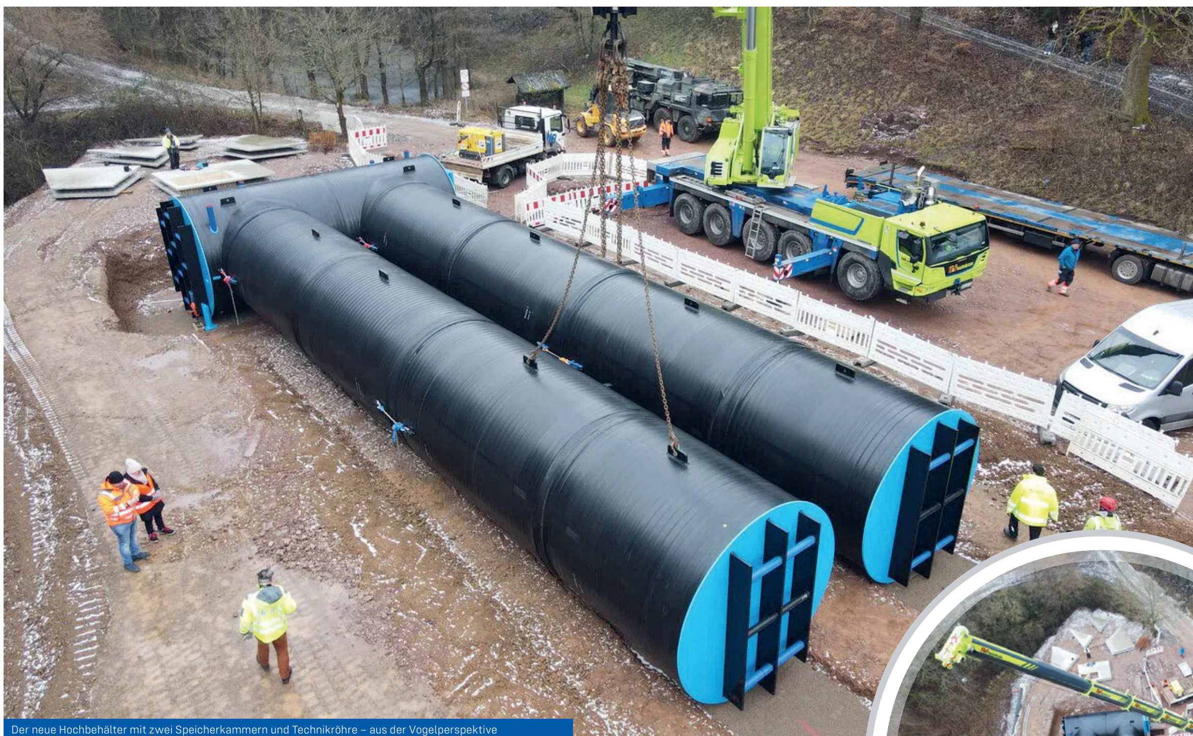
Der neue Hochbehälter mit zwei Speicherkammern und Technikröhre – aus der Vogelperspektive
