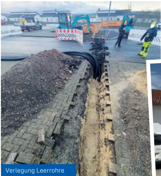
Verlegung Leerrohre
